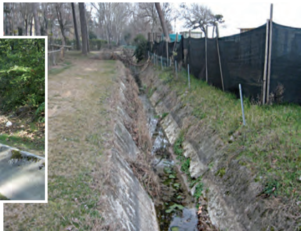
La canaletta che non dovremo più vedere.
